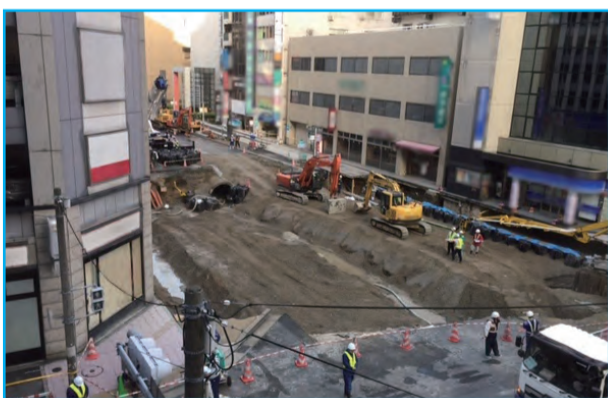
流動化処理土完了
